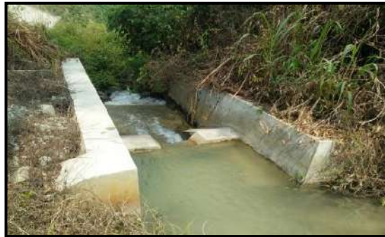
Gambar 4.15 Bukaan Pintu Air
