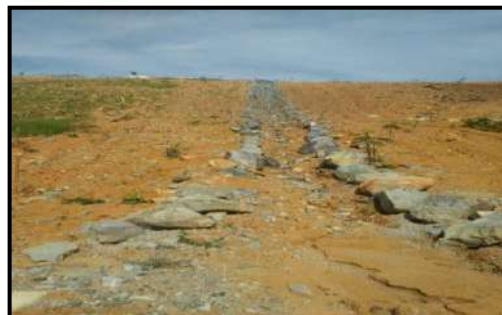
Gambar 4.14 Saluran Drainase di Waste Dump
